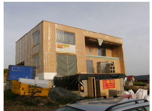
Holzhaus im Bau Wood & Roof PGmbH
