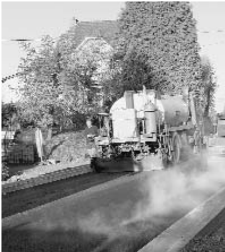
Die Arbeiten an der Ortsdurchfahrt in Born enden im Sommer.
