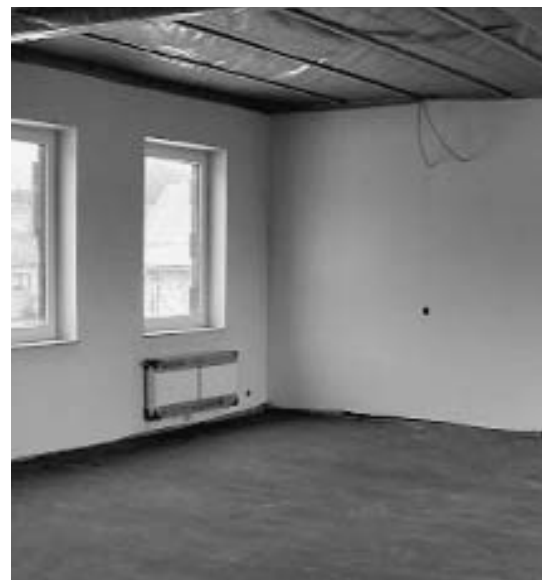
Die Bauarbeiten an der neuen Gemeindeschule in Schoppen gehen zügig voran.
