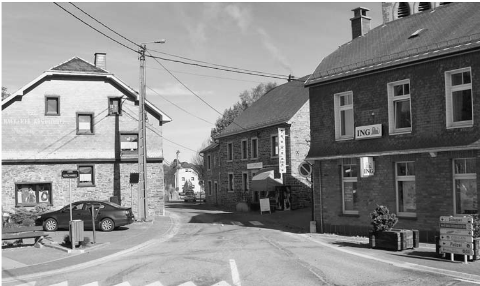
Der Kirchweg in Amel befindet sich in einem schlechten Zustand.
