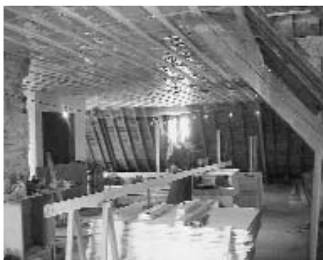
Der Ausbau der 2. Etage des Gemeindehauses geht zügig voran.
