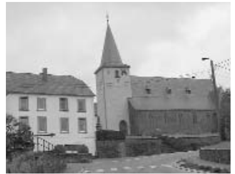
Kirchturm von Meyerode in neuem Glanz.
