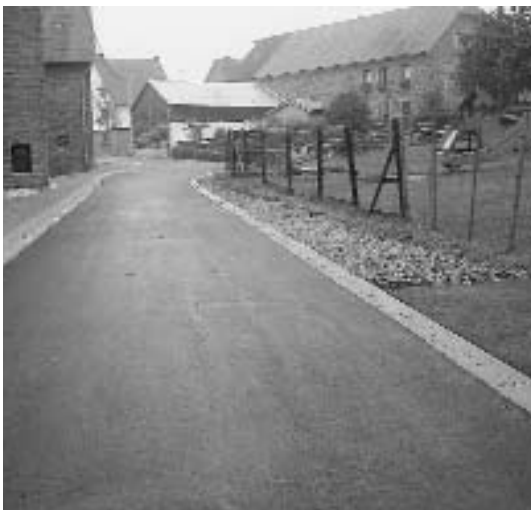
Die Schulwegsicherung in Heppenbach ist mittlerweile abgeschlossen.
