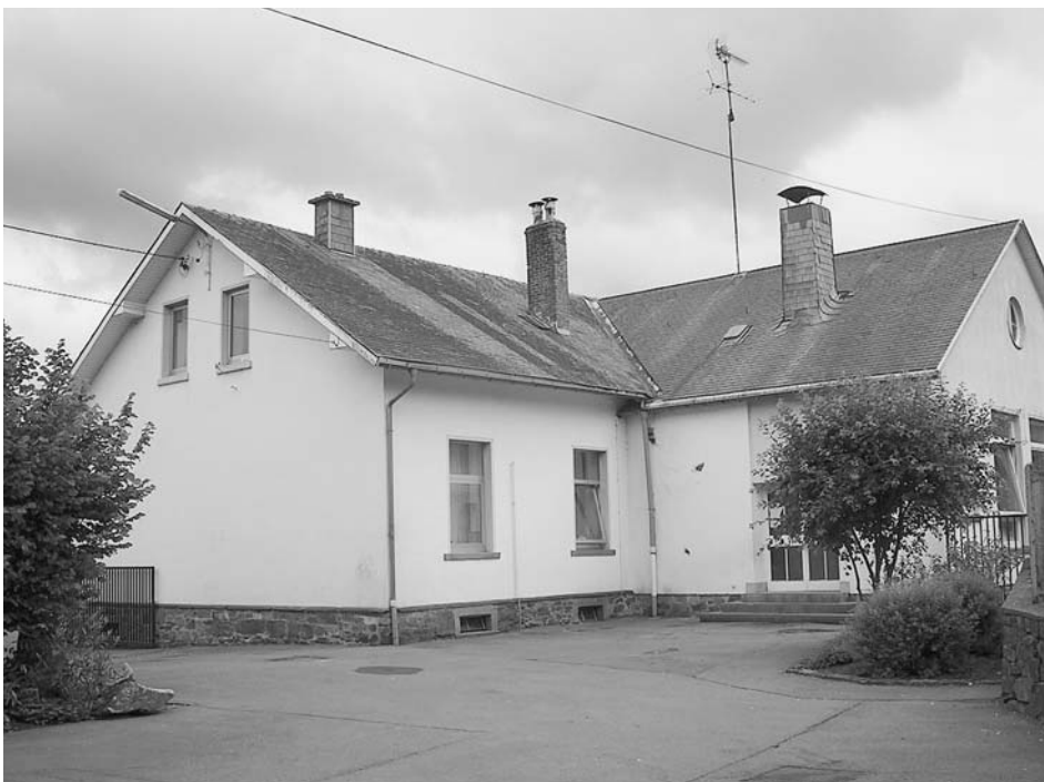
Die Schoppener Schule wird bald abgerissen.
