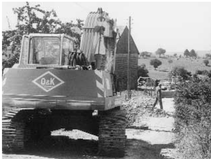
Der allgemeine Zustand des Wegenetzes in der Gemeinde Amel wird als gut beschrieben, doch besteht an verschiedenen Stellen Handlungsbedarf.
